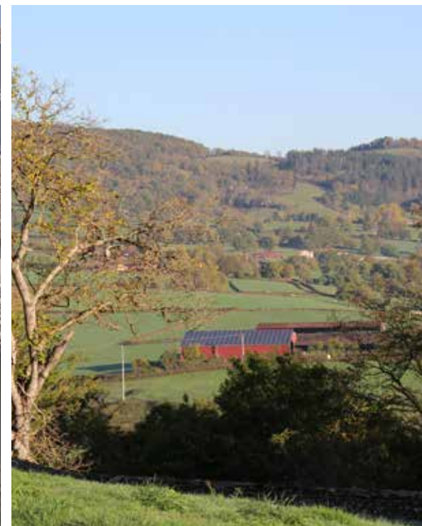
Vue d'installations sur bâti agricole, Mazille
