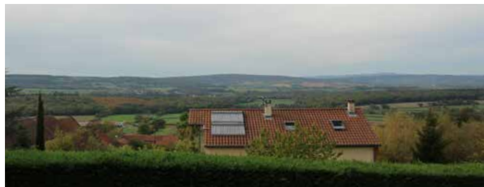
Vue d'installations sur habitat récent, Cortambert
