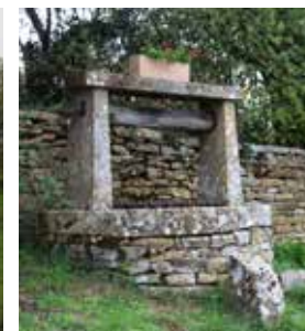
Vue d'un puits, Saint-Clément-sur-Guye
