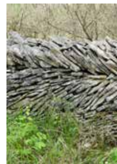
Muret de pierres sèches Cortevaix
