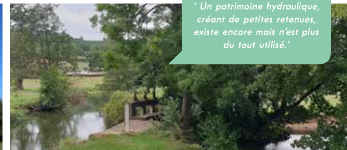
Vue d'un ouvrage hydraulique Siggy-le-Châtel
