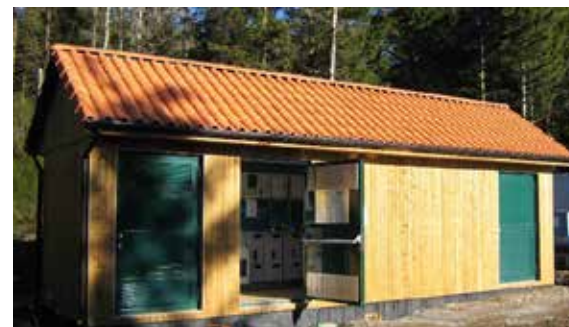
Exemple de poste de livraison. Source : https://parc-eolien-plaine-de-champagne.fr/poste-de-livraison-2/
