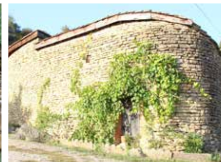
Mur en pierres appareillées Château
