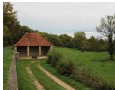
Vue d'un lavoir, Salornay-sur-Guye
