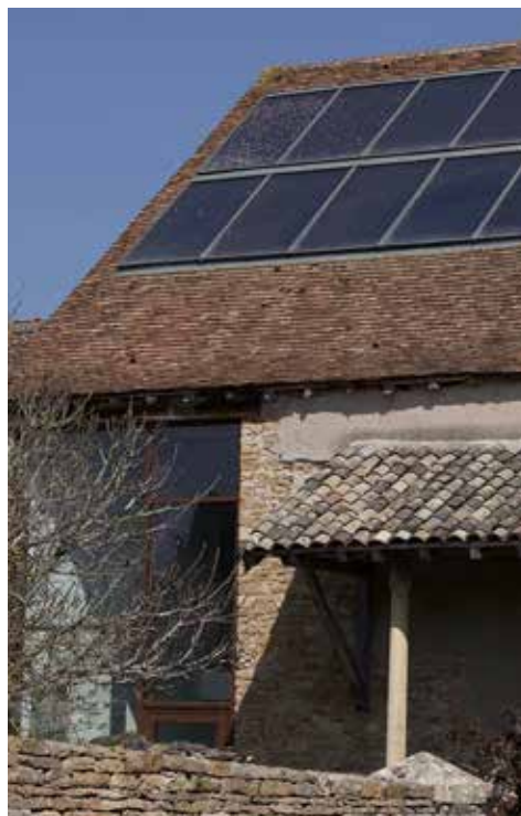
Vue d'installations sur bâti patrimonial, Bonnay
