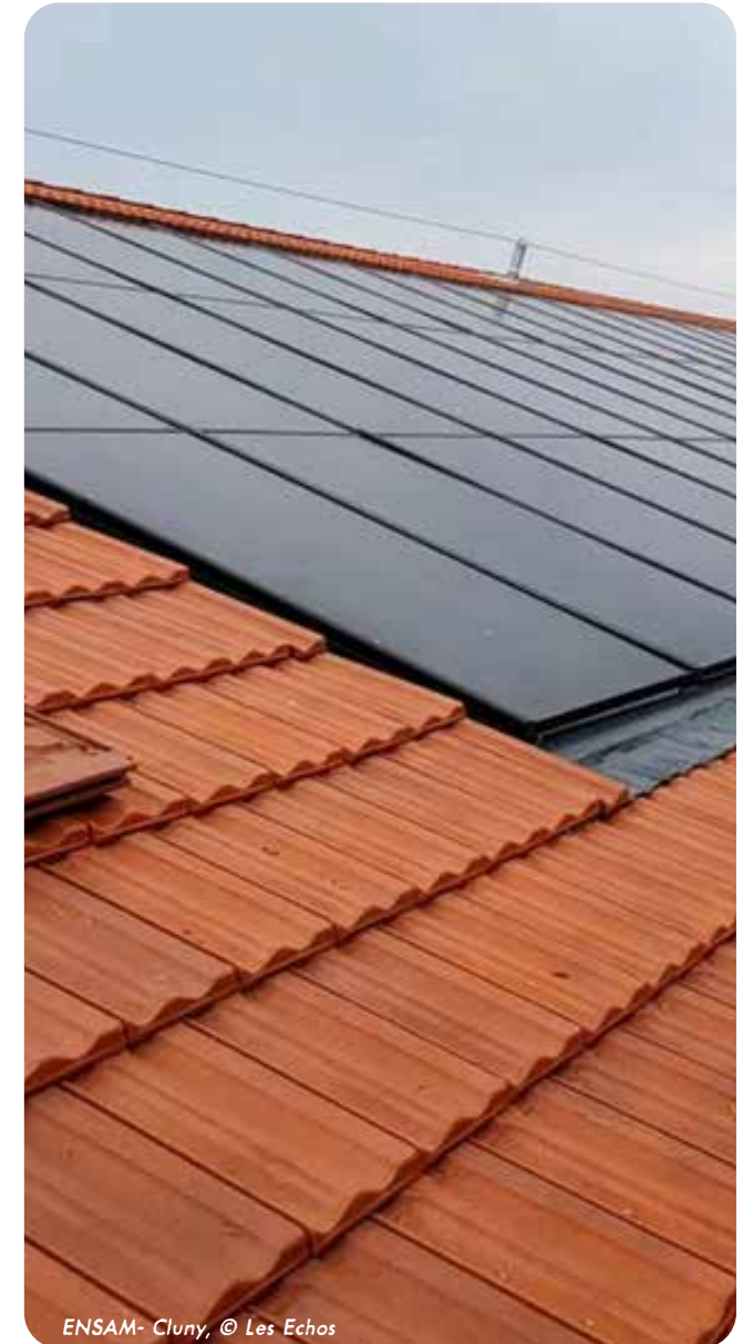
Rénovation énergétique en toiture
