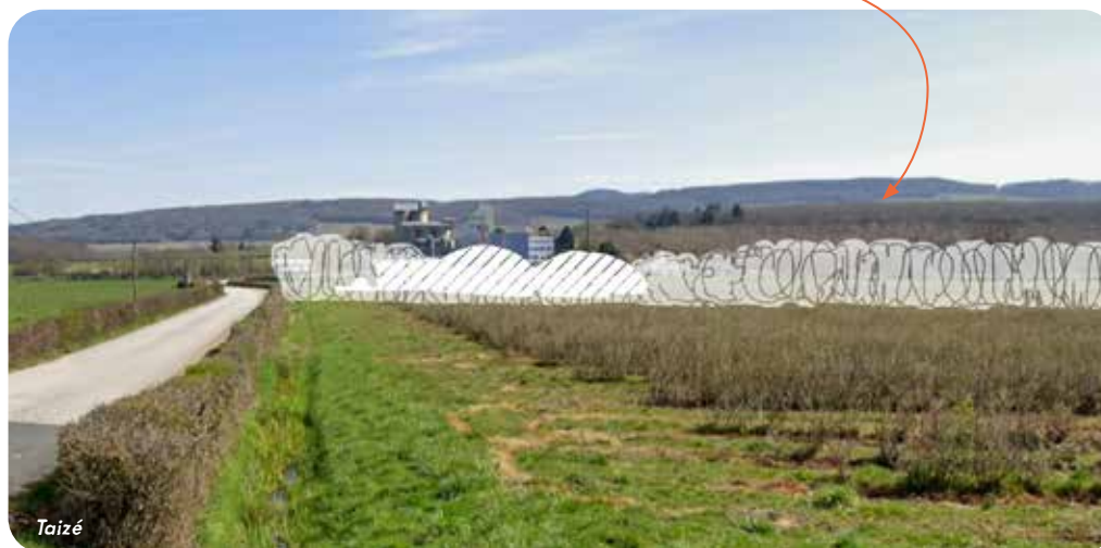
Exemple d'intégration paysagère d'une centrale de méthanisation
