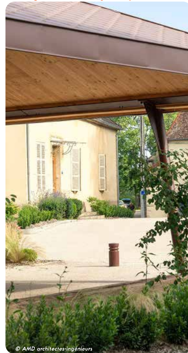
Aménagement du centre-bourg de Joncy
