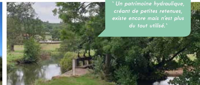
Vue d'un ouvrage hydraulique Sigy-le-Châtel
