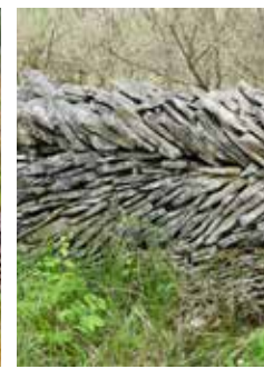
Muret de pierres sèches Cortevaix
