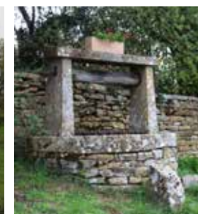
Vue d'un puits, Saint-Clément-sur-Guye
