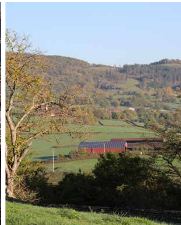
Vue d'installations sur bâti agricole, Mazille
