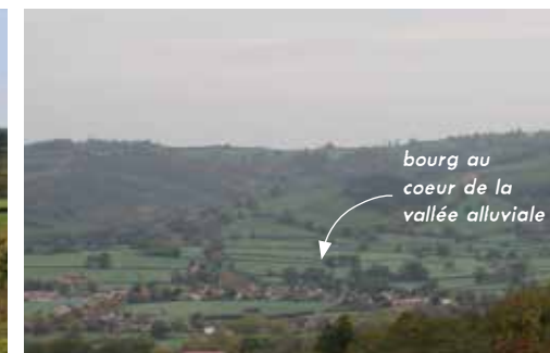
Installation dans le fond de vallée de la Guye Joncy
