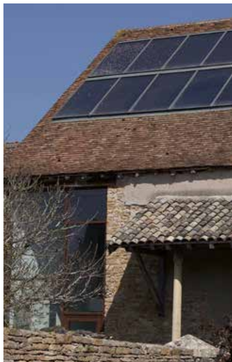
Vue d'installations sur bâti patrimonial, Bonnay
