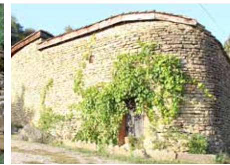
Mur en pierres appareillées Château
