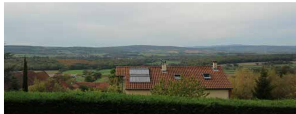
Vue d'installations sur habitat récent, Cortambert
