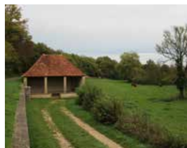
Vue d'un lavoir, Salornay-sur-Guye
