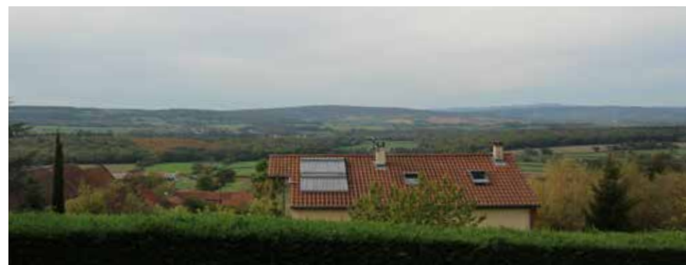
Vue d'installations sur habitat récent, Cortambert
