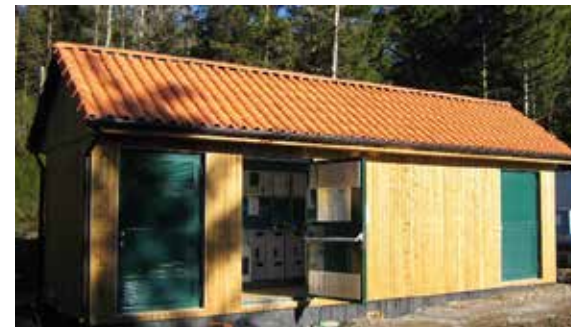
Exemple de poste de livraison. Source : https://parc-eolien-plaine-de-champagne.fr/poste-de-livraison-2/
