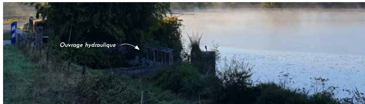
Vue des ouvrages hydrauliques non-exploités de l'étang de Pierre au Grain, Pressy-sous-Dondin
