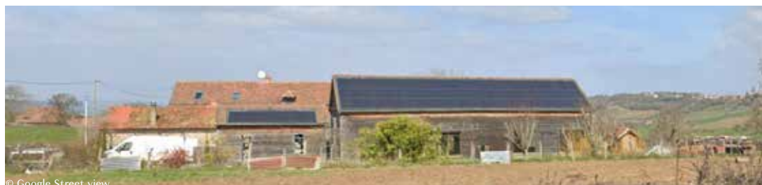
Vue d'installations sur projet de réhabilitatoin / extension, La-Vineuse-sur-Frégande
